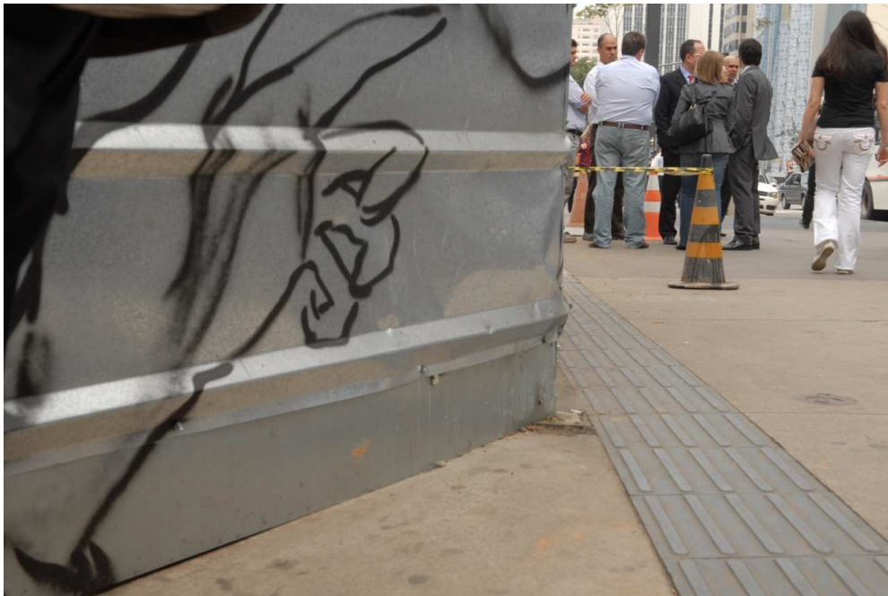
Foto 23 – Detalhe do tapume da obra no alinhamento do piso tátil direcional.
