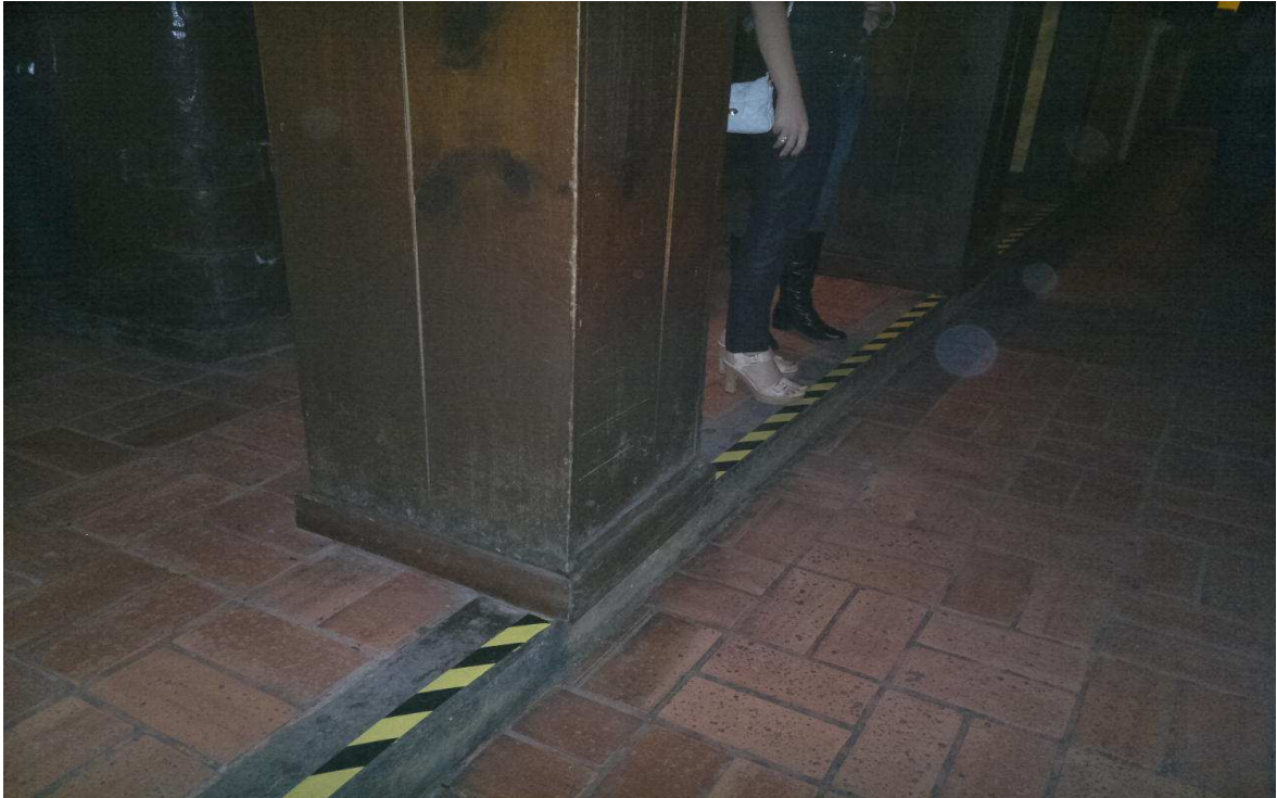
Foto 14 – Vista de um degrau no piso na separação de diferentes ambientes, sem rampa nas proximidades.
