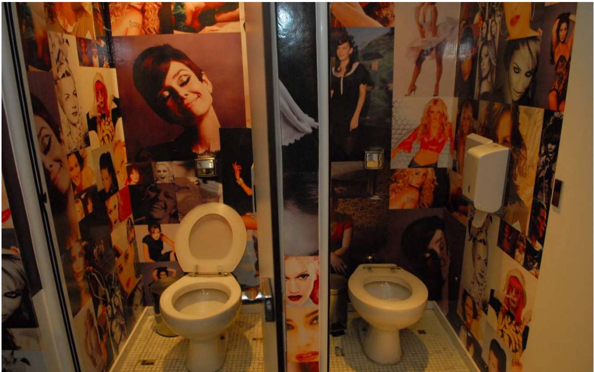
Foto 49 – Vista das bacias sanitárias de um dos sanitários, sem condições de acessibilidade.
