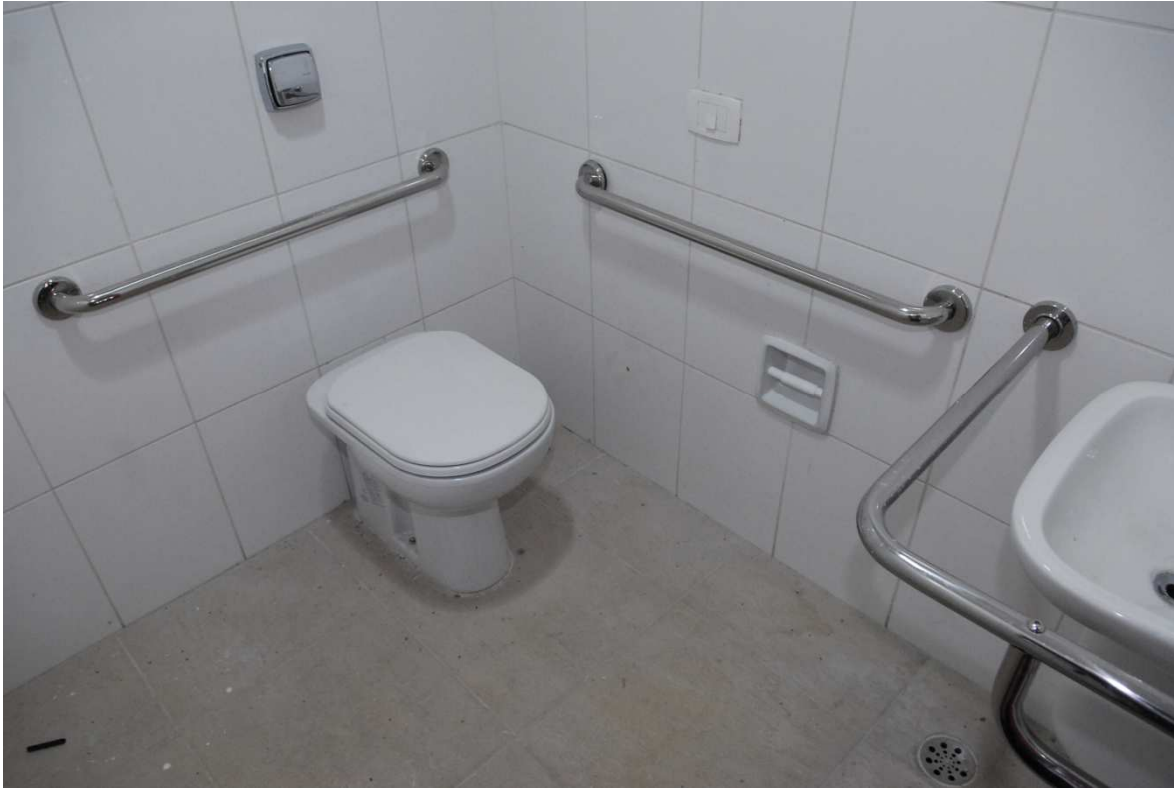
Foto 38 – Vista de um dos sanitários inspecionados, com as barras de apoio para as pessoas com deficiência e mobilidade reduzida.
