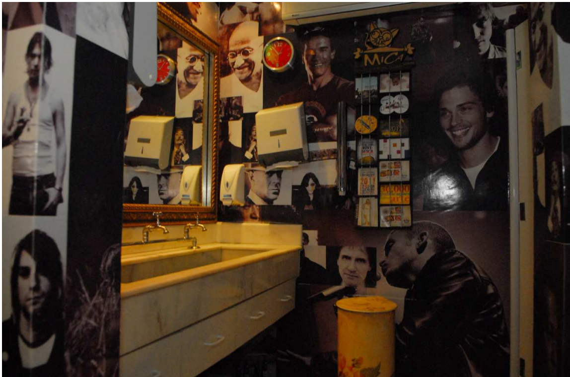
Foto 50 – Vista do lavatório de um dos sanitários, também sem condições de acessibilidade.
