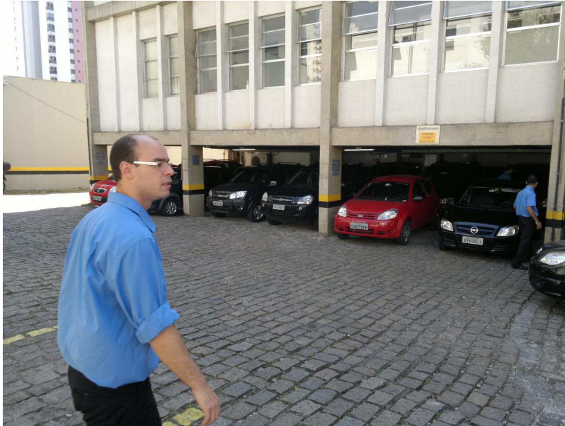
Piso do estacionamento em paralelepípedo
