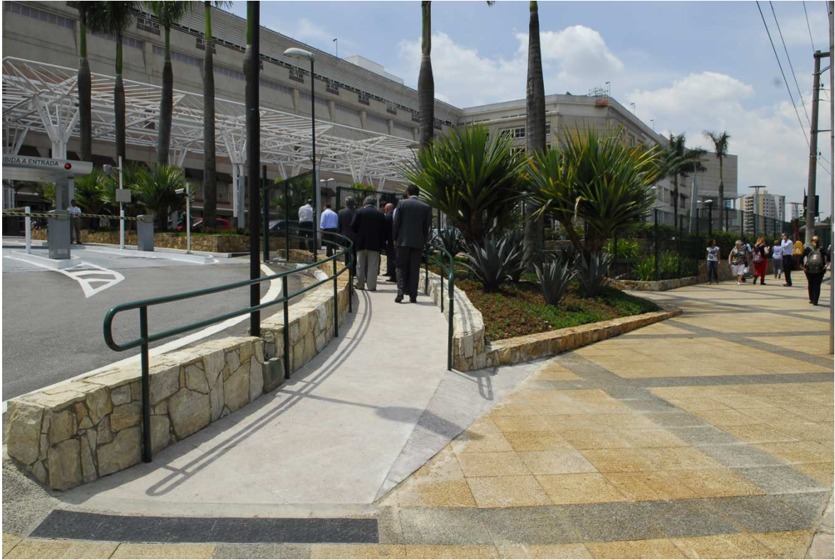
Foto 33 – Vista da rampa de acesso existente na entrada do Shopping Center.
