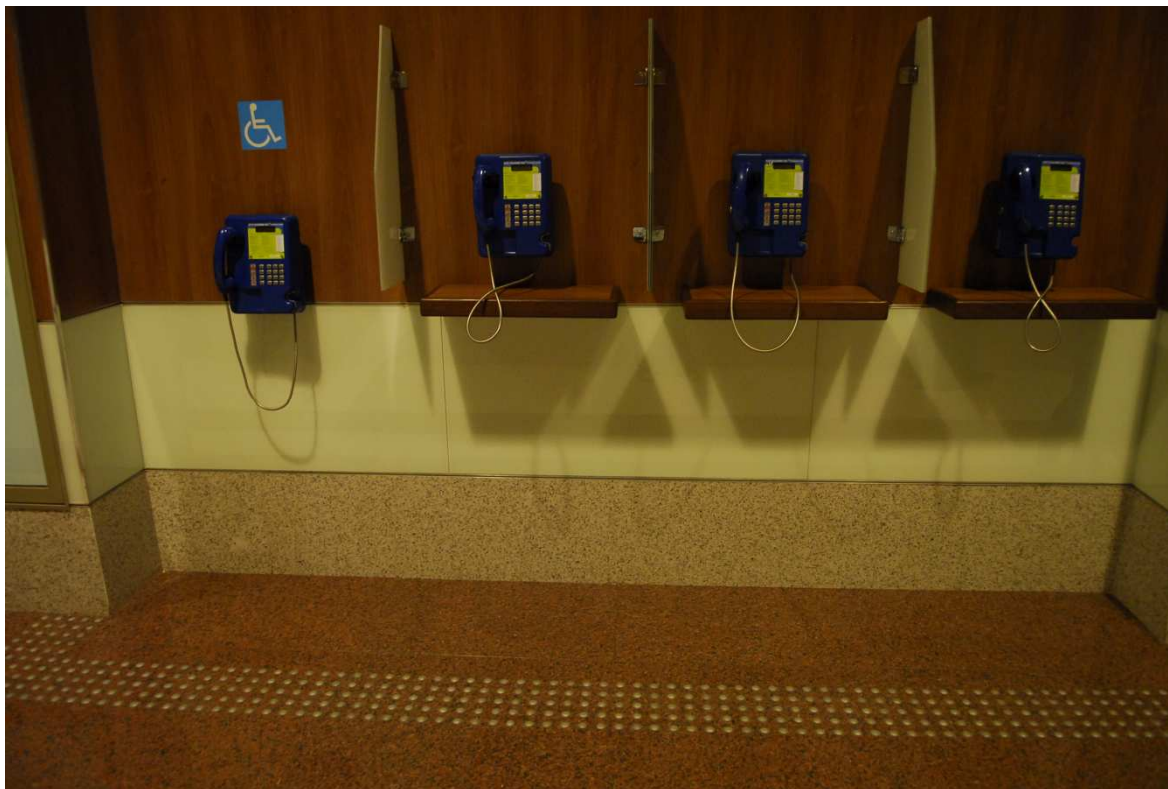
Foto 30 – Vista da sinalização tátil de piso junto a aparelhos telefônicos e também o aparelho telefônico com altura compatível ao usuário de cadeira de rodas.
