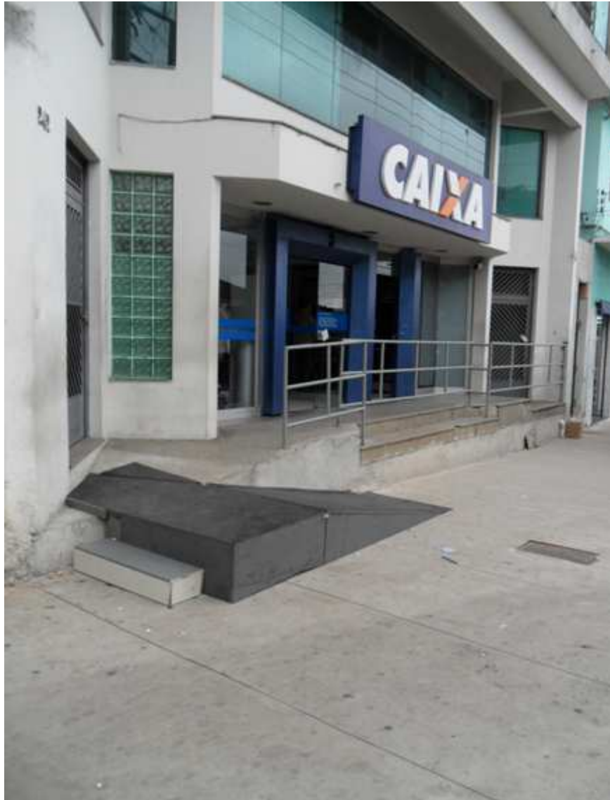
Foto 06 – Outra vista da peça em rampa instalada na entrada da agência bancária, visando proporcionar uma melhor acessibilidade aos usuários.
