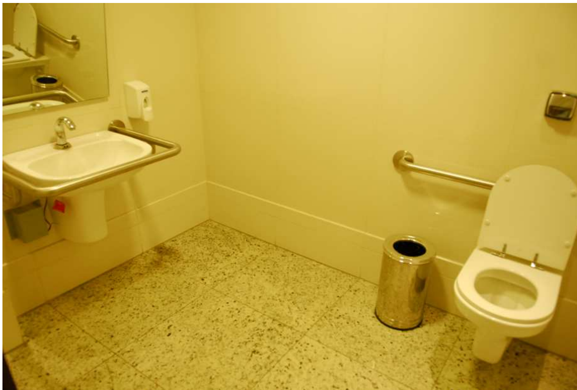
Foto 32 – Vista de um sanitário em condições adequadas de utilização por pessoas com deficiência física e mobilidade reduzida.
