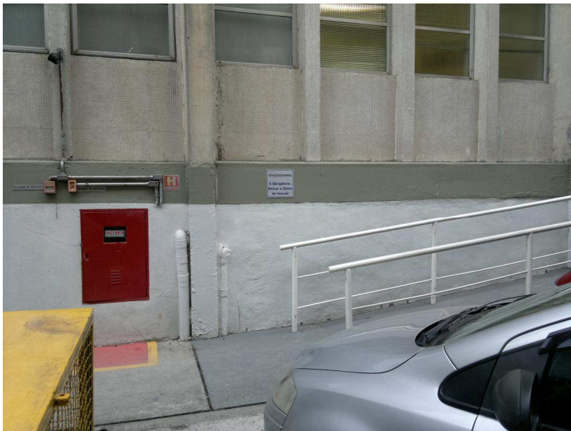
Vista da entrada da rampa para deficientes.
