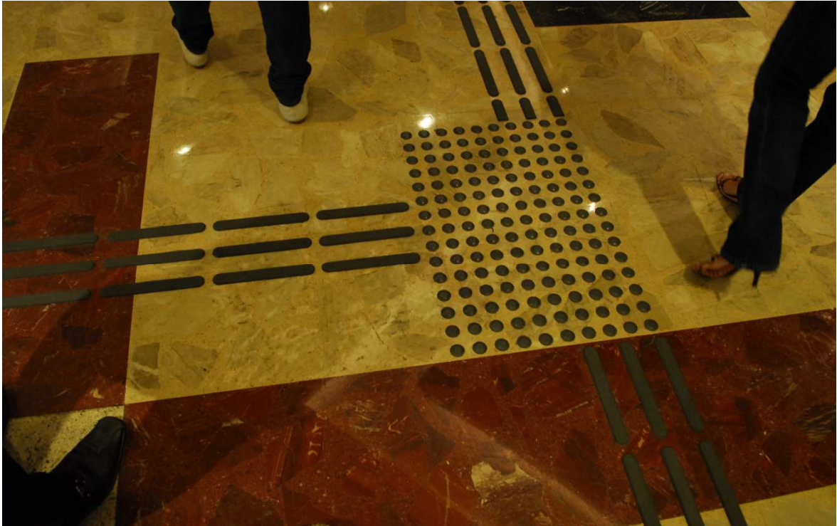
Foto 29 – Vista de outro local com sinalização tátil de alerta e direcional em piso no interior da edificação.
