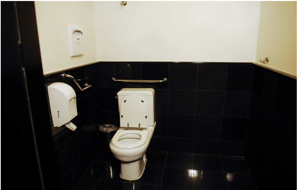
Foto 41 – Vista de um sanitário coletivo da edificação, com cumprimento parcial das exigências de acessibilidade.
