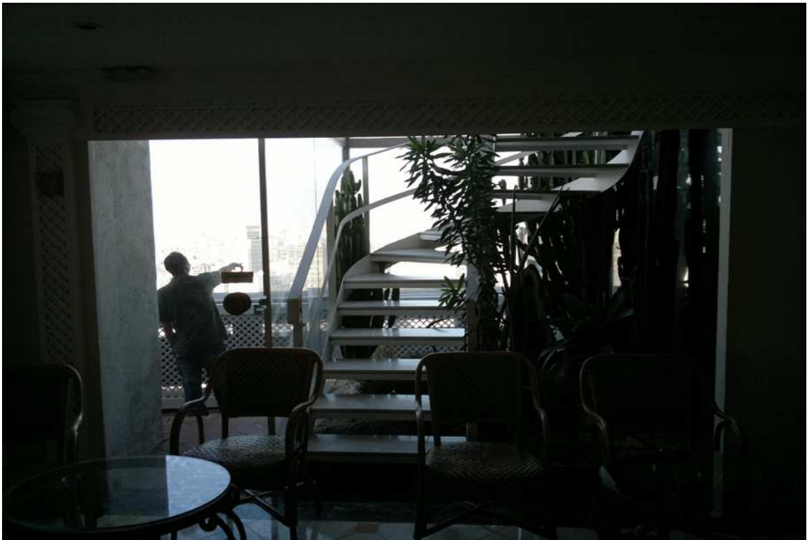
Foto 18 – Vista de escada de acesso ao ambiente situado em um piso superior do restaurante, sem condições de acessibilidade.
